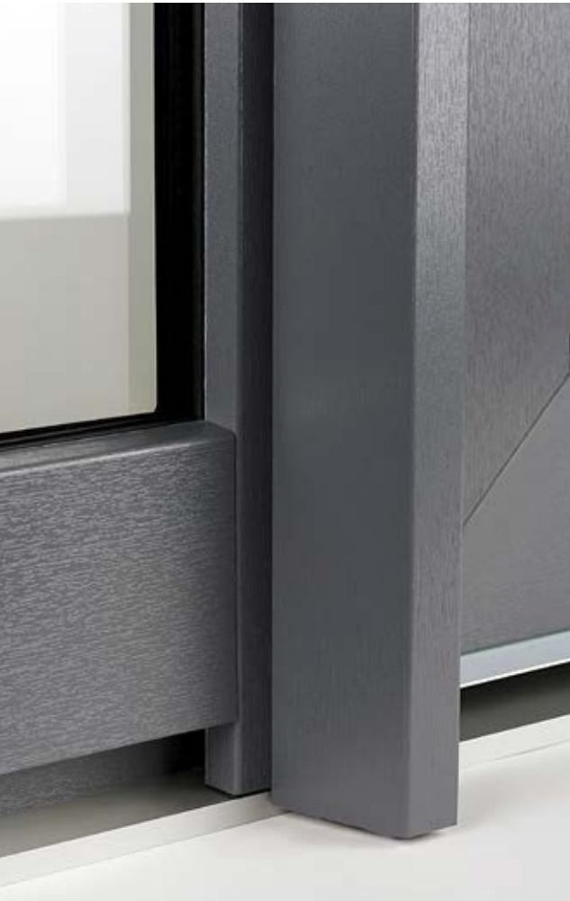
Statikpfosten bei Kunststoff-Haustüren mit Seitenteil
